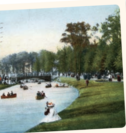
Canal Belle Isle
